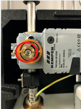
Die Kerbe der Ventilspindel steht nun waagrecht.
